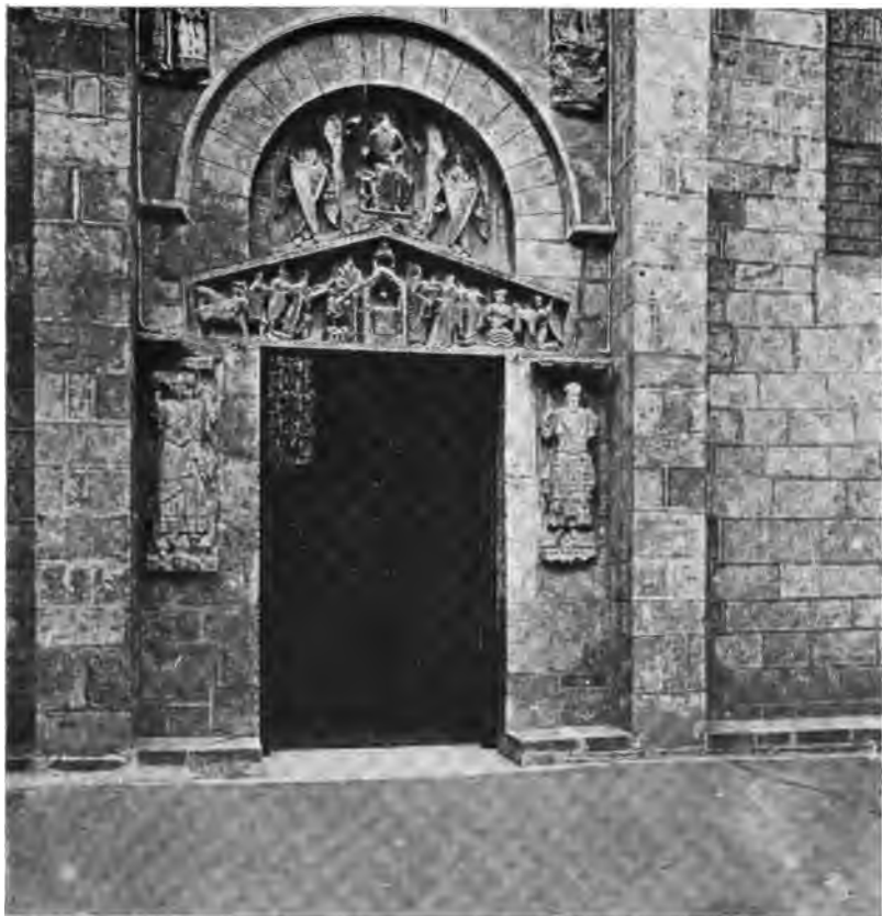
Fig. 57. — Portail sud de l'église Notre-Dame du Port à Clermont-Ferrand. Linteau ayant au milieu sa hauteur maxima pour résister à la flexion.
